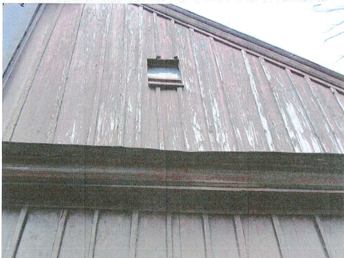
Fot. nr 7 Fot. nr 8 Kościół p.w. Podwyższenia Krzyża Świętego w Podolu-Górowej; widok od strony północnej i wschodniej nad zakrystią. Widoczny stan zachowania deskowania, łuszczenie się farby, zsiniałe objęte korozją biologiczną drewno; skorodowane blaszane pokrycie dachowe.
