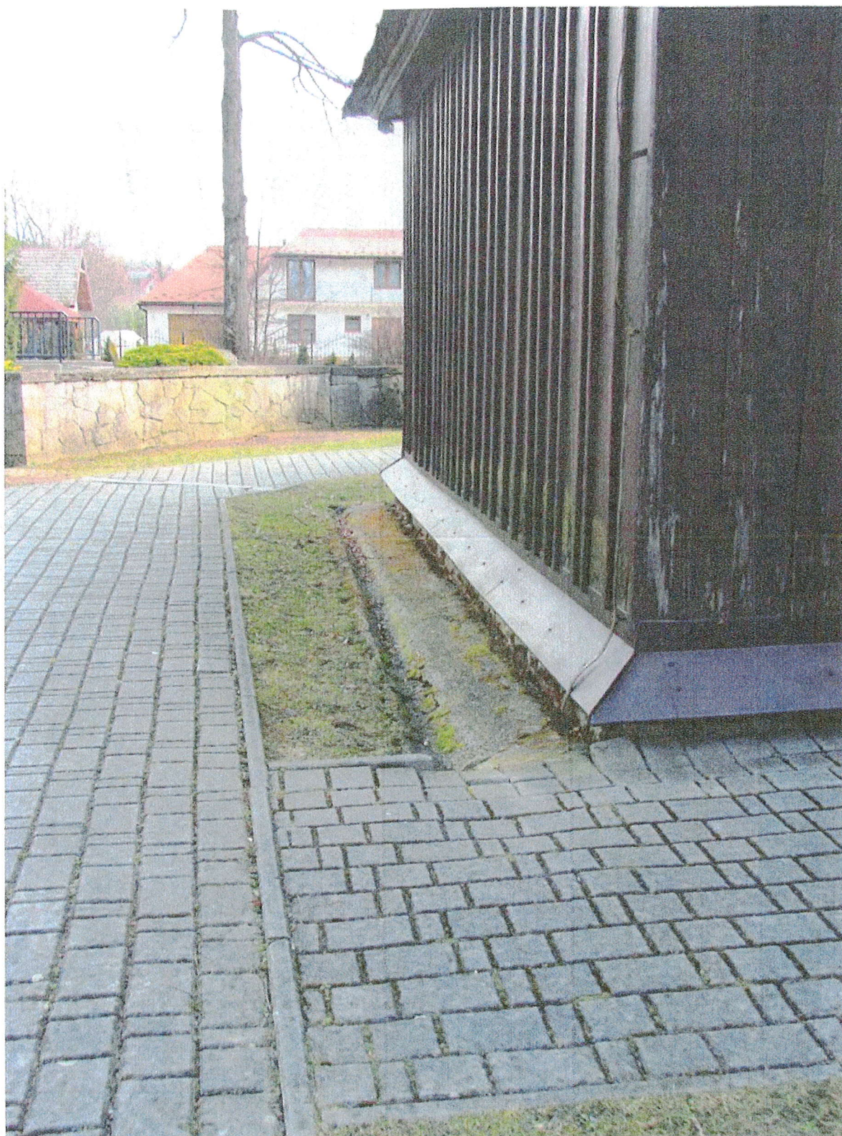
Fot. nr 19 Kościół p.w. Podwyższenia Krzyża Świętego w Podolu-Górowej; widok od strony północnej. Widoczny stan zachowania deskowania, łuszczenie się farby, zsiniałe objęte korozją biologiczną drewno, betonowa opaska wokół kościoła, korozja ścianki fundamentowej pokrytej zacierką cementową i koloniami mchów i porostów; system odprowadzania wody opadowej.
