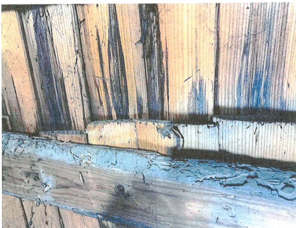
Fot. nr 31, 32 Kościół p.w. Podwyższenia Krzyża Świętego w Podolu-Górowej; widoczny stan pokrycia gontowego, konstrukcja wieży.
