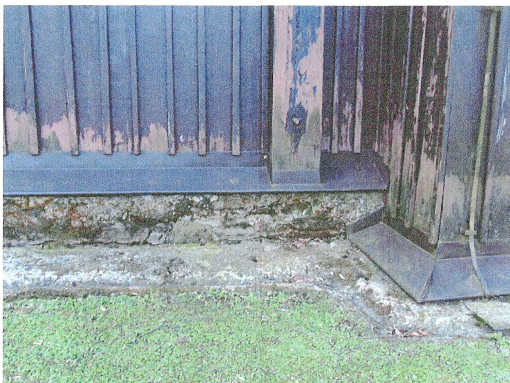
Fot. nr 15 Fot. nr 16 Kościół p.w. Podwyższenia Krzyża Świętego w Podolu-Górowej; widok od strony wschodniej. Widoczne wtórne drzwi wejściowe, stan zachowany deskowania, łuszczenie się farby, zsiniałe objęte korozją biologiczną drewno, betonowa opaska wokół kościoła, korozja ścianki fundamentowej pokrytej zacierką cementową i koloniami mchów i porostów.
