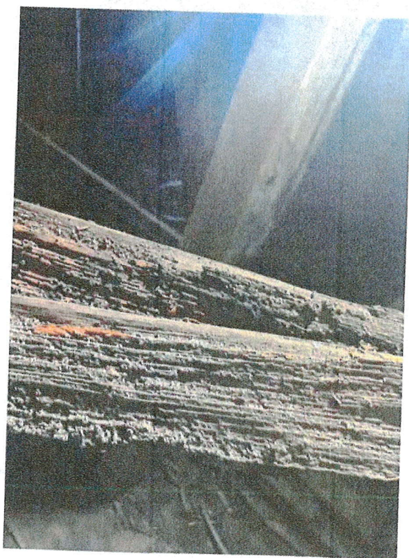
Fot. nr 35 Kościół Podwyższenia Krzyża Świętego w Podolu-Górowej; widoczny stan więzby dachowej
