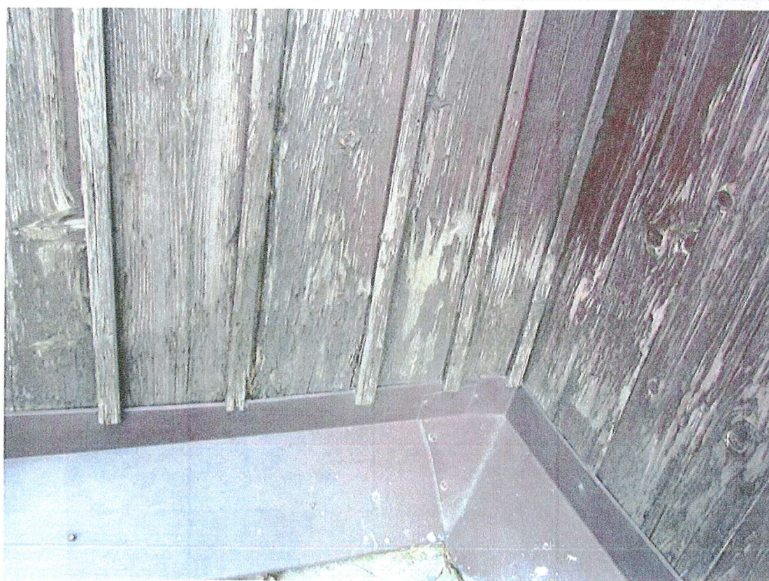
Fot. nr 9 Fot. nr 10 Kościół p.w. Podwyższenia Krzyża Świętego w Podolu-Górowej; widok od strony północnej i południowej. Widoczny stan zachowania deskowania, łuszczenie się farby, zsiniałe objęte korozją biologiczną drewno; skorodowane blaszane pokrycie dachowe.
