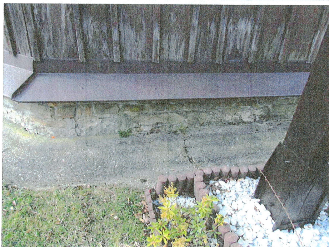
Fot. nr 13 Fot. nr 14 Kościół p.w. Podwyższenia Krzyża Świętego w Podolu-Górowej; widok od strony północnej. Widoczny stan zachowania deskowania, łuszczenie się farby, zsiniałe objęte korozją biologiczną drewno; betonowa opaska wokół kościoła.
