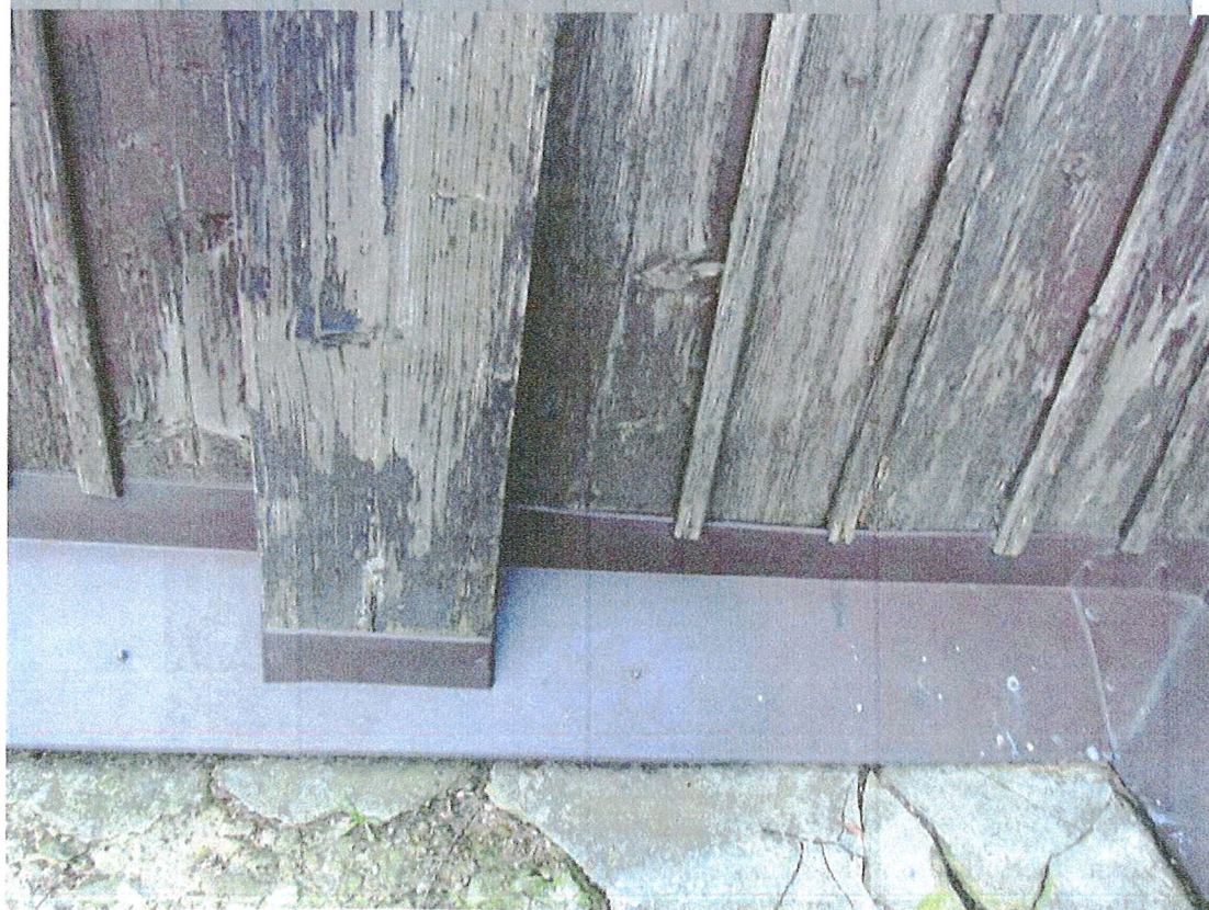
Fot. nr 11 Fot. nr 12 Kościół p.w. Podwyższenia Krzyża Świętego w Podolu-Górowej; widok od strony północnej. Widoczny stan zachowania deskowania, łuszczenie się farby, zsiniałe objęte korozją biologiczną drewno.
